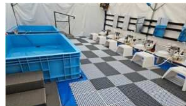
仮設入浴設備
