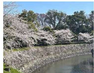
河川改修 (景観に配慮した護岸整備)
