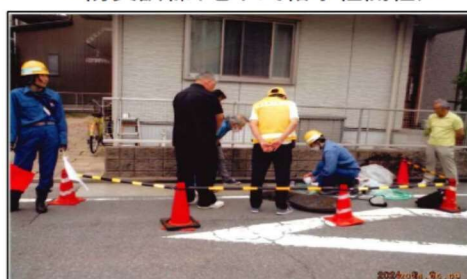
<防災訓練（地下式給水栓開栓）>
