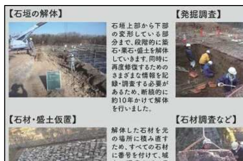
石垣の修復(抜粋)
