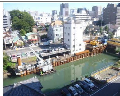
護岸改修と河道掘削
