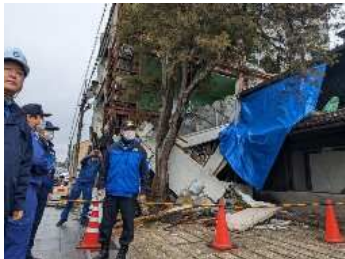
建物倒壊（七尾市）
