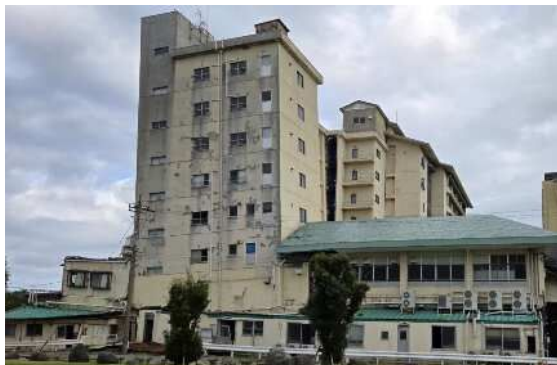
和倉温泉旅館被害（建物が大きく傾斜）
