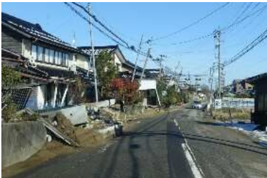
液状化被害（内灘町）
