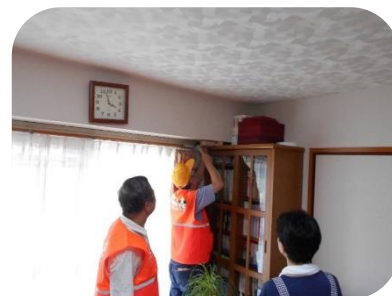
家具の転倒防止作業
