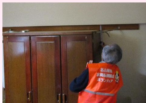
家具の転倒防止作業
