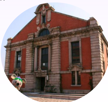
鍋屋上野浄水場 第一ポンプ所
