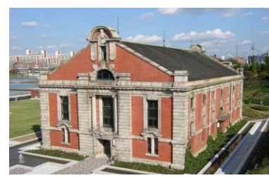
【鍋屋上野浄水場】
