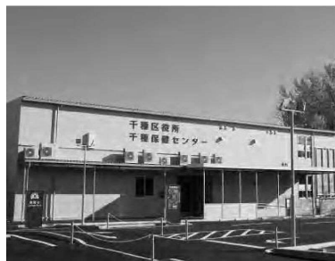
▲ 千種区役所仮設庁舎
