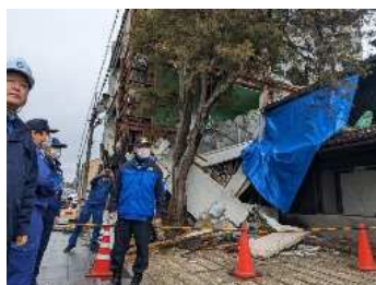
建物倒壊（七尾市）
