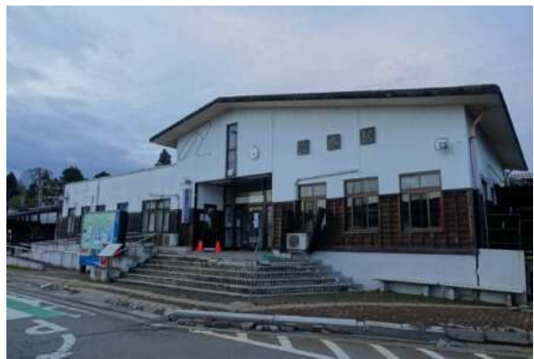
亀裂・段差被害 （のと鉄道穴水駅）
