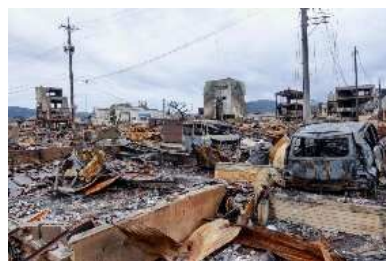
火災被害（輪島市）
