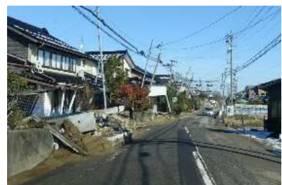
液状化被害（内灘町）
