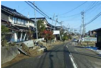
液状化による電柱被害 (かほく市)
