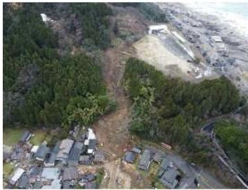
山腹崩壊（珠州市）
