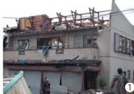
屋根瓦・葺材の飛散、木造住宅は壁の損傷や、最悪の場合倒壊
