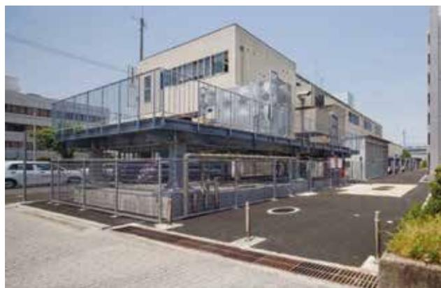
非常用発電機と受水槽を屋外の架台上に移設
