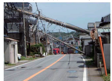
〈電柱の倒壊イメージ〉
