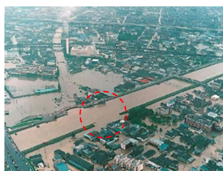
〈東海豪雨における新川左岸破堤箇所〉
