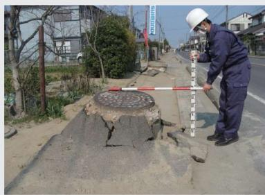
千葉県内で発生した液状化によるマンホールの浮き上がり
