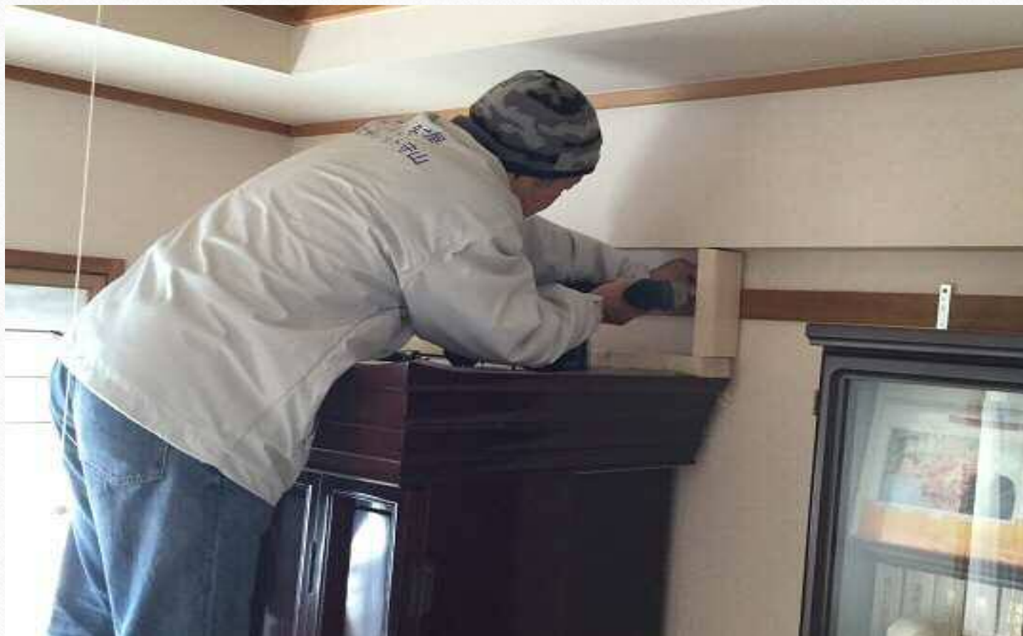
家具固定の様子
