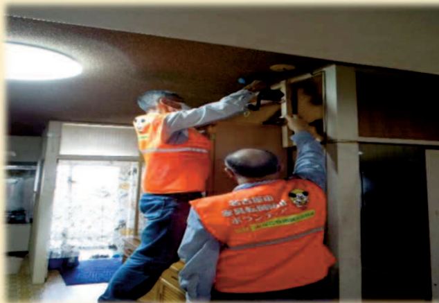
家具転倒防止施工
