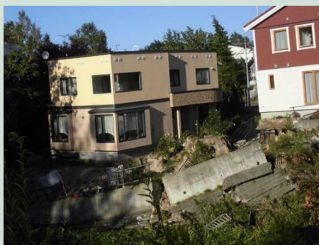
建物倒壊 道路損壊と同出典
