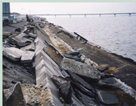
堤防沈下 東京建築局ホームページより
