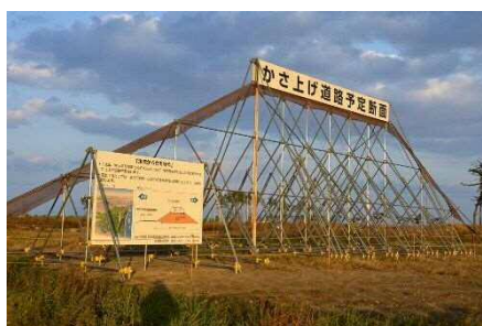
堤防機能を付加した嵩上げ道路の整備 【仙台市】
