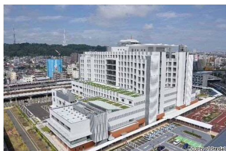
市立病院の移転【仙台市】 (出典：仙台市 Web サイト)
