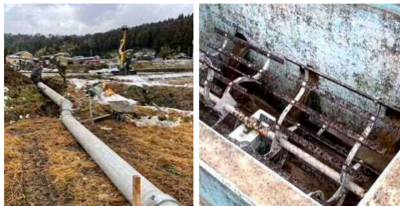
仮設導水管の布設
