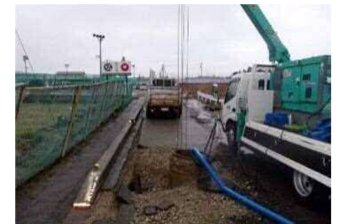
応急復旧(七尾市)
