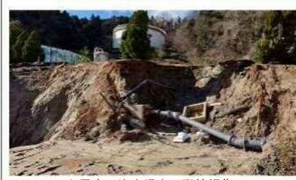
七尾市の浄水場内の配管損傷
