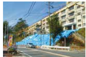
鳴海町の土砂災害現場 斜面崩壊によりガードレールとの間に挟まれ、男性1名の尊い命が失われた
