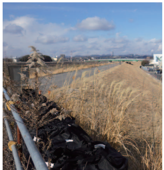
写真⑭ 2011年(平成23年)の台風15号による豪雨被害の後、かさ上げ等された庄内川堤防
