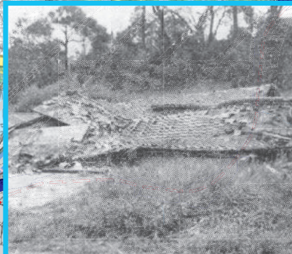
写真③ 伊勢湾台風で倒壊した龍泉寺公会堂
