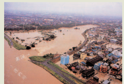
東海豪雨の際の洗堰の様子
