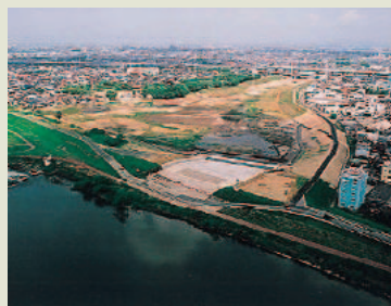
現在の洗堰の様子(庄内川河川事務所提供)
