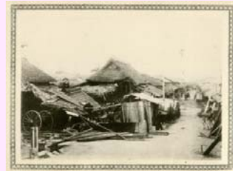
大曽根坂下家屋崩壊
