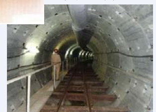
堀川左岸雨水調整池 工事中の写真
