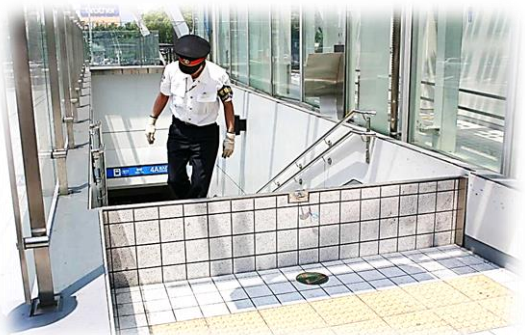
地下鉄の止水板 (立ち上げ方式)
