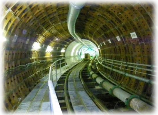
緊急水整備事業の実施 (建設中の中村中部雨水調整池)
