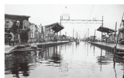
【冠水した道徳駅のホーム】
