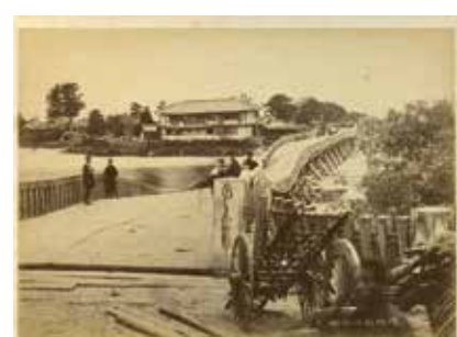
【折れ曲がった枇杷島橋】
