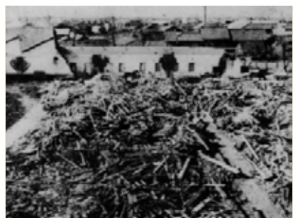
【被災した市内の様子】
