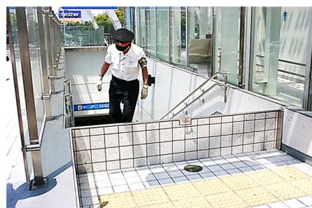
地下鉄の止水板（立上げ方式）
