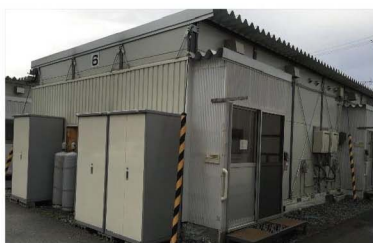
応急仮設住宅
