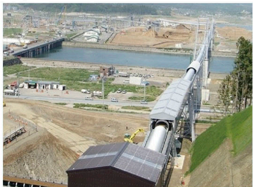
かさ上げ工事を加速させた土砂運搬用の巨大ベルトコンベアー 「希望のかけ橋」
