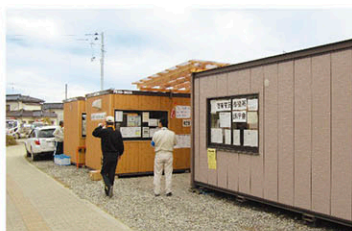
被災直後の陸前高田市役所仮庁舎 (コンテナハウスを利用)
