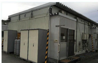
応急仮設住宅
