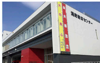
消防防災センター
