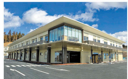
高台に再建された岩手県立高田病院
