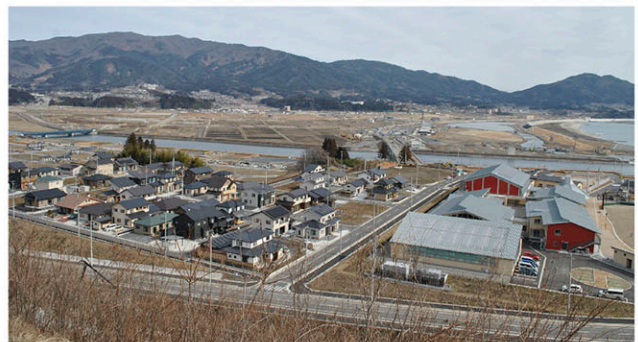
土地区画整理事業による高台の宅地整備
