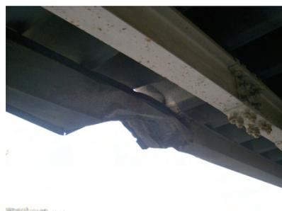
津波を受けて損傷した渡り廊下の屋根
