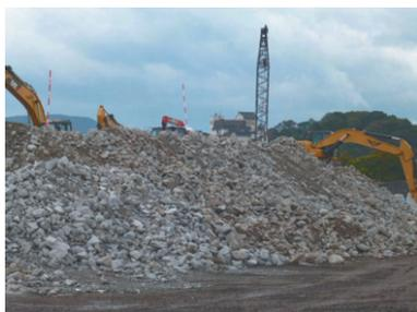
破碎・選別後、復興資材として再生利用されたコンクリートくず
