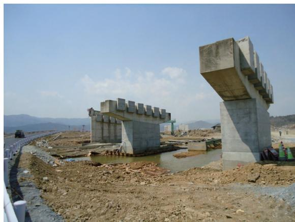
被災した国道45号線、沼田川の橋桁（陸前高田市）
