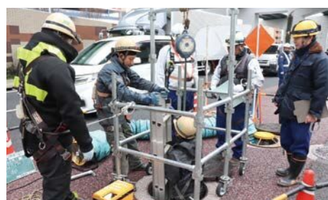
下水管の点検
