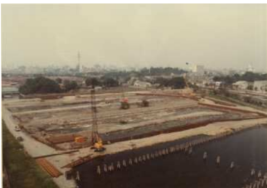
埋立て工事 （昭和56（1981）年頃、南からの眺望）
