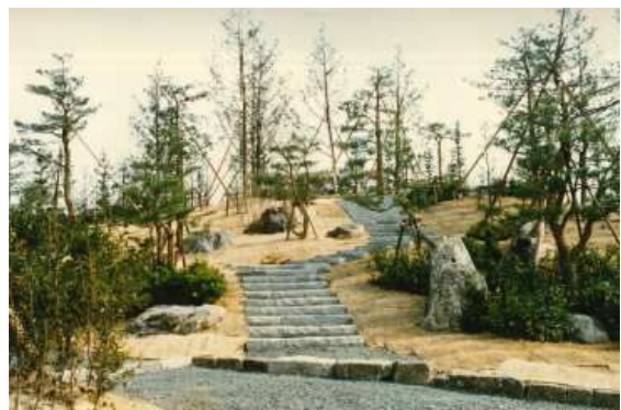
庭園築造工事 （昭和62（1987）年頃）
