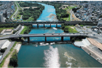
▲庄内川枇杷島地区(令和8年8月撮影)
