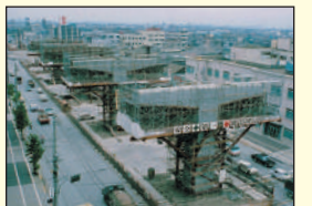
▲名古屋高速道路建設時の様子(提供:名古屋高速道路公社)
