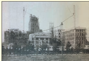
▲建設中の市役所庁舎・議事堂 (提供:市政資料館)
