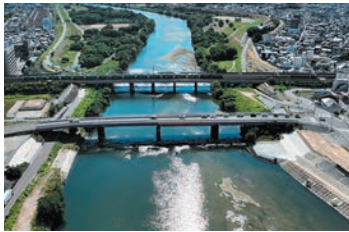
▲庄内川枇杷島地区(令和8年8月撮影)
