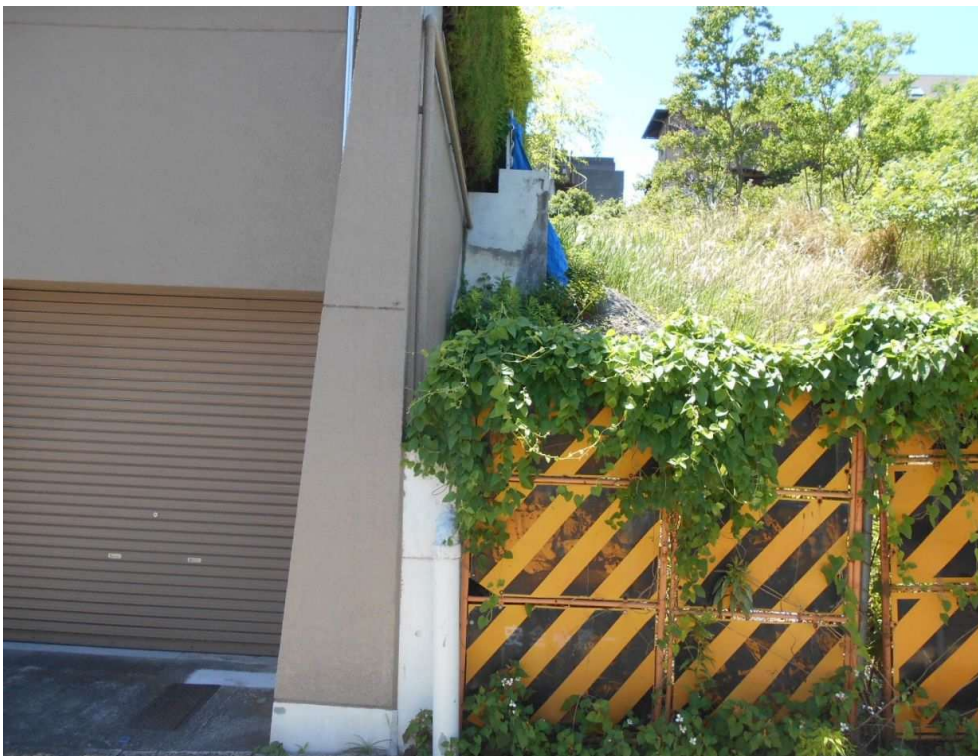
写 真 ④(北側から撮影)
