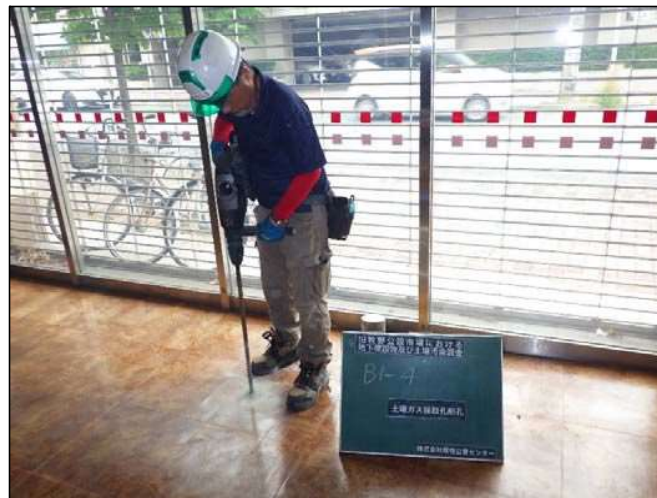
土壌ガス削孔状況
