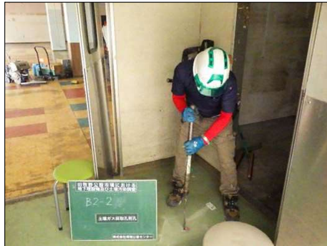
土壌ガス削孔状況
