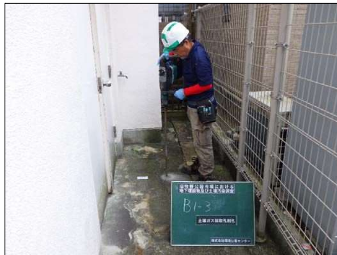
土壌ガス削孔状況
