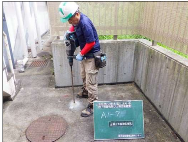
土壌ガス削孔状況
