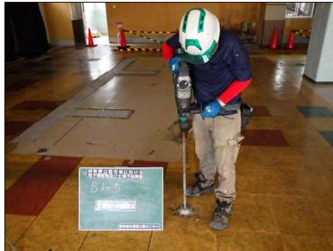
土壌ガス削孔状況
