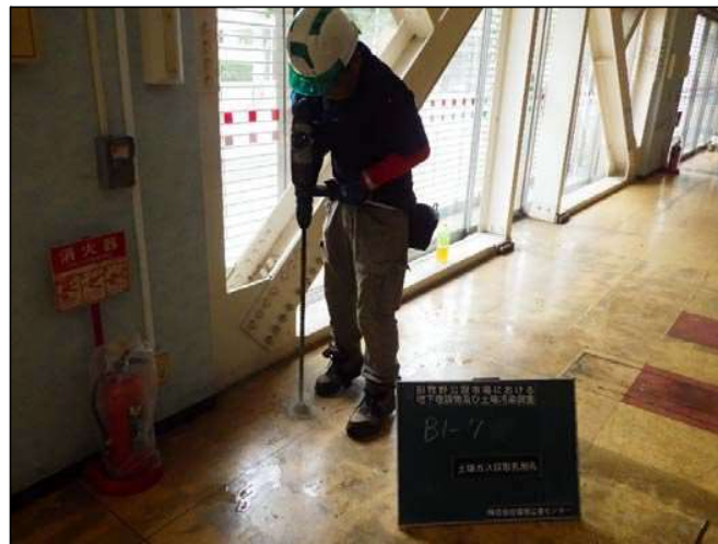
土壌ガス削孔状況
