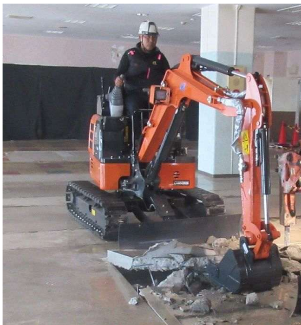
図 2.2-1 調査に使用した小型バックホー
