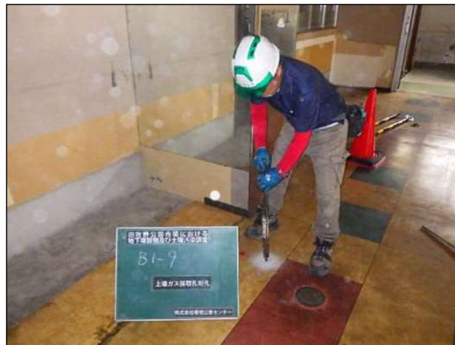
土壌ガス削孔状況
