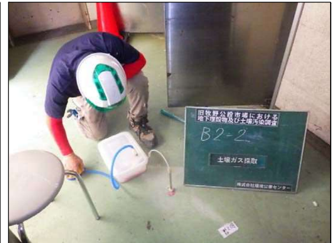
土壌ガス採取状況
