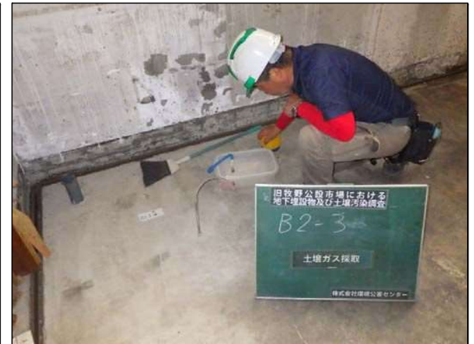
土壌ガス採取状況
