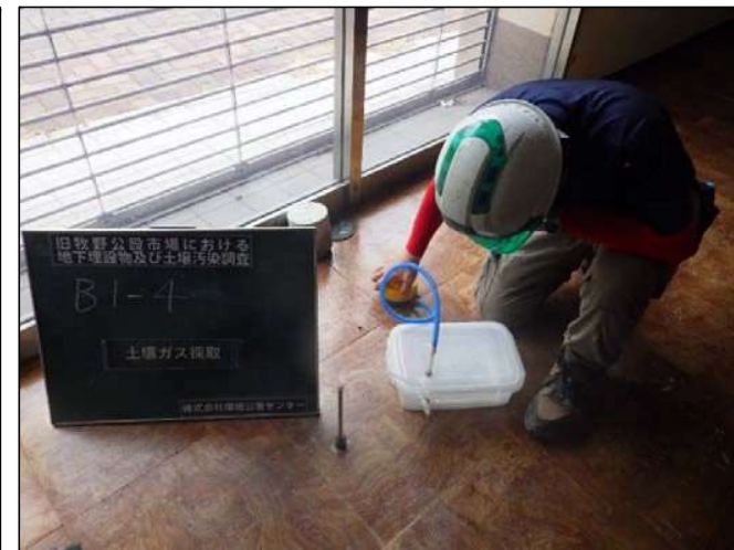
土壌ガス採取状況
