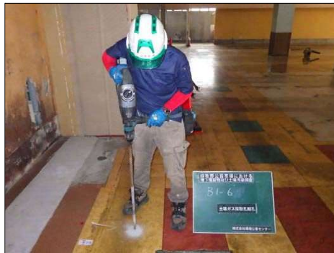
土壌ガス削孔状況
