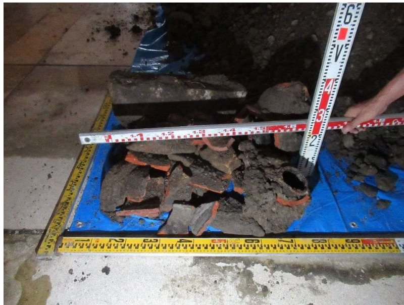
図 2.2-6 埋設物の状況（下層）
