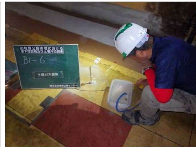
土壌ガス採取状況
