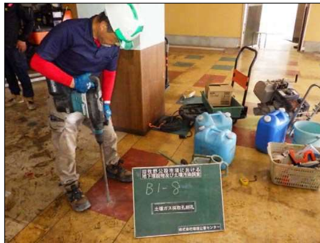
土壌ガス削孔状況
