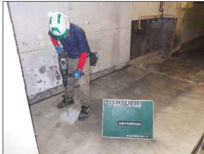
土壌ガス削孔状況
