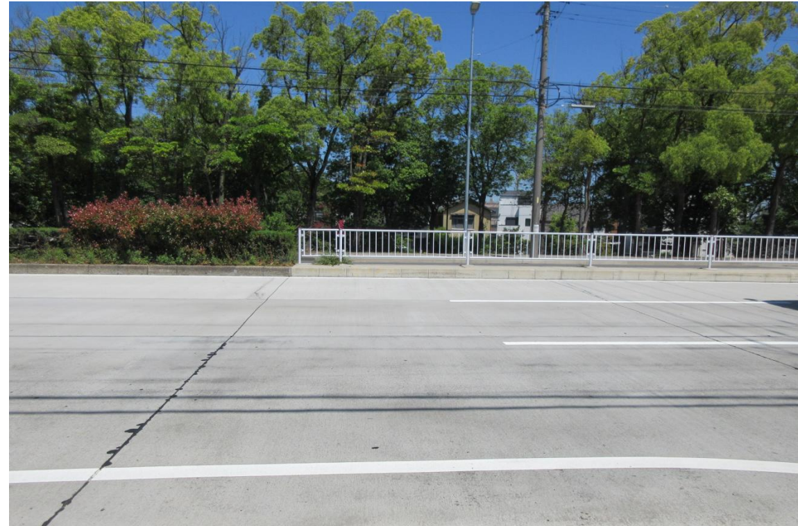
新しいコンクリート舗装
