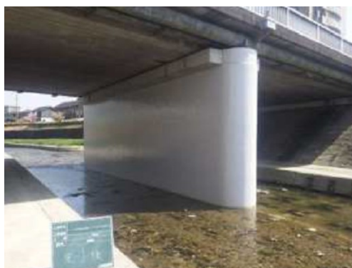
図2.3.6 震災に対する取組（橋りょうの耐震補強）
