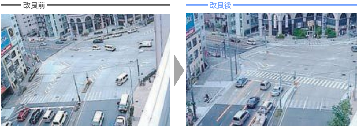
図2.2.8 交差点改良工事の例（コンパクト化）
