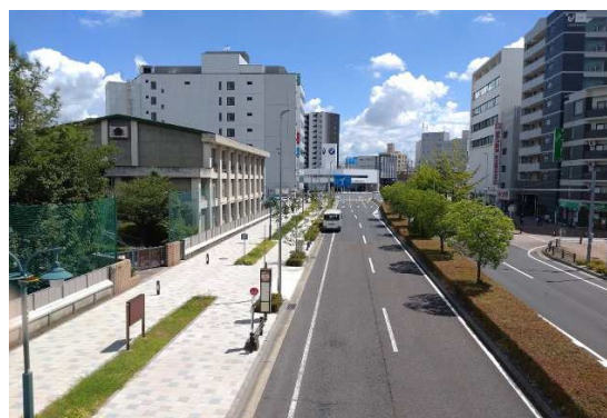
図2.3.7 震災に対する取組（無電柱化）
