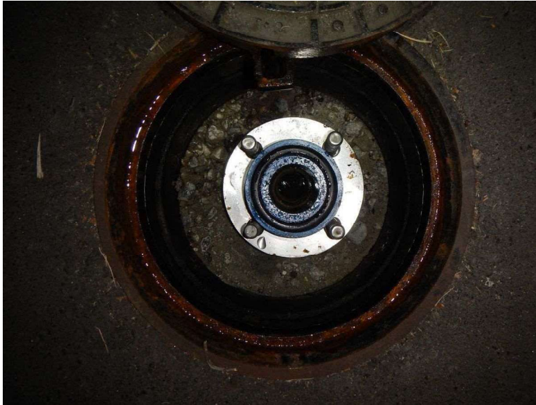
高圧洗浄作業 西側排水桝
