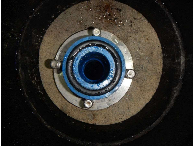
高圧洗浄作業 東側排水桝
