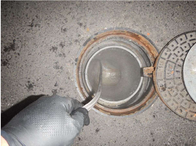
高圧洗浄作業 西側排水桝
