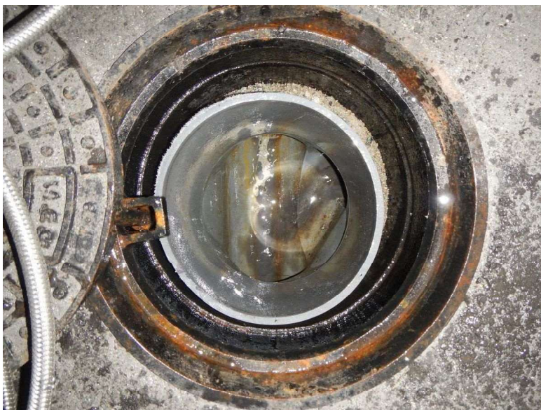
高圧洗浄作業 東側排水樹
