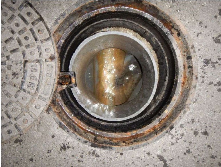
高圧洗浄作業 東側排水樹
