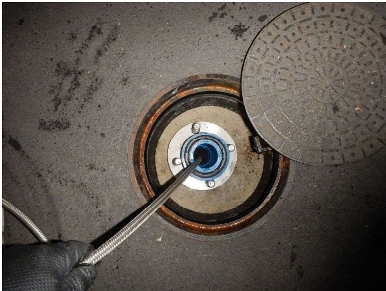
高圧洗浄作業 東側排水桝
