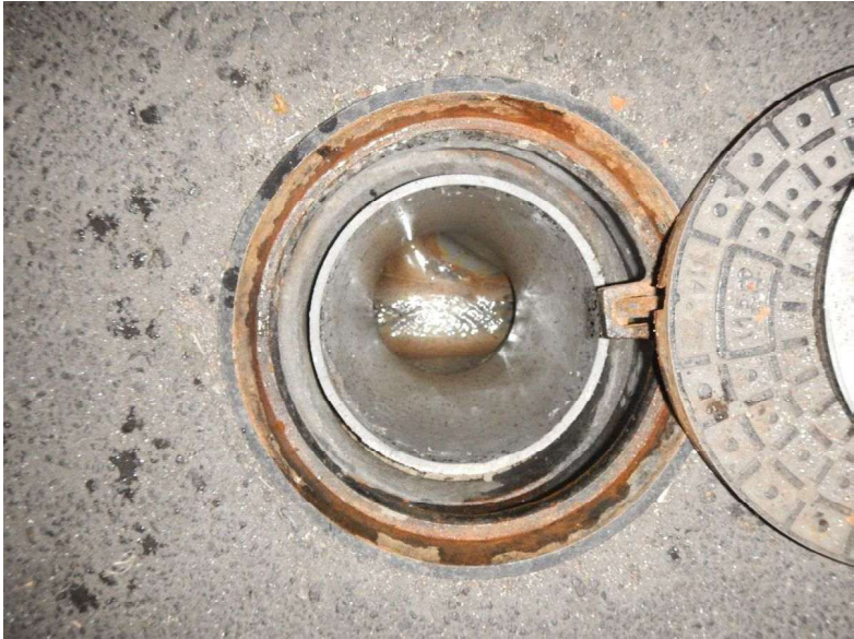
高圧洗浄作業 西側排水桝
