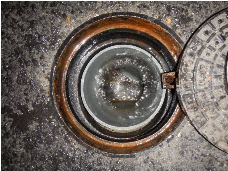
高圧洗浄作業 西側排水桝
