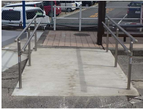
スロープの設置状況
