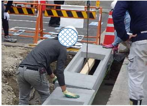
玉掛け作業の状況
