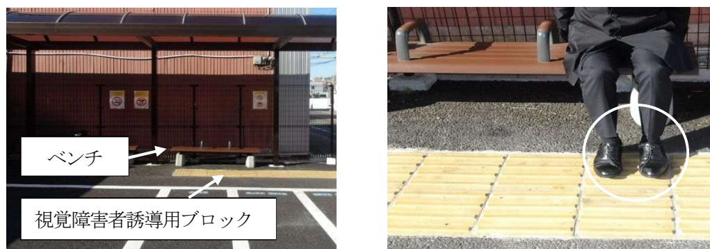
視覚障害者誘導用ブロックとベンチの全景及び位置関係
