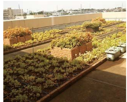
鳴海工場 屋上の緑化
