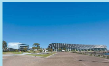
名古屋市国際展示場 第1展示館 及び コンベンションセンター
