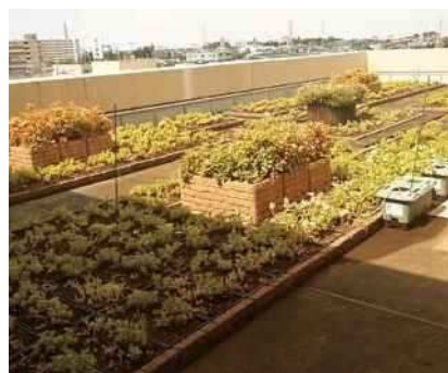
鳴海工場 屋上の緑化
