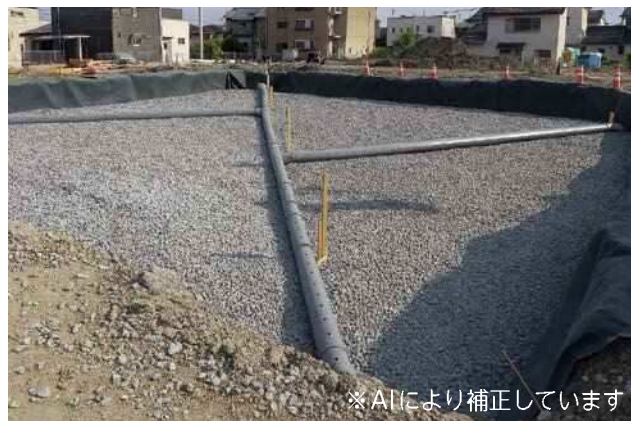
図：グラウンドに雨水貯留浸透の仕組みを取り入れたかから公園（港区）
