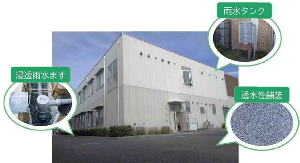
図：雨水貯留浸透施設を設置した上下水道局東部営業センター（千種区）
