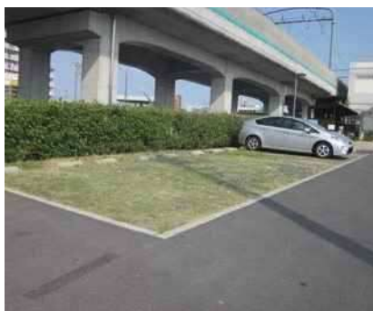
緑土木事務所 駐車場の緑化（舗装面の工夫）
