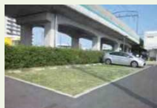
▲緑土木事務所駐車場の緑化（舗装面の工夫）
