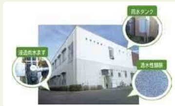
▲雨水貯留浸透施設を設置した上下水道局東部営業センター
