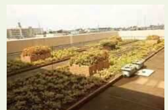
▲鳴海工場屋上の緑化
