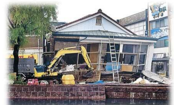
石川県七尾市における公費解体の様子
